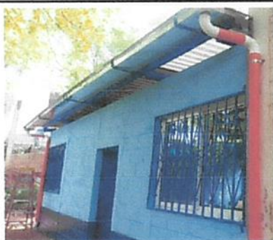
Foto 5: Colocación de Canales y Caidas de Agua
