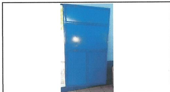
Foto 12: Cambio de Chapa y Pintura en Puerta Principal de Aula
