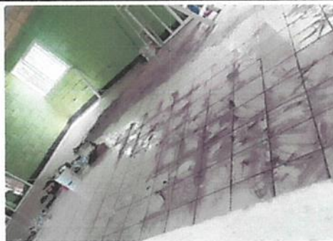
Foto 6: Colocación de Piso ceramico
