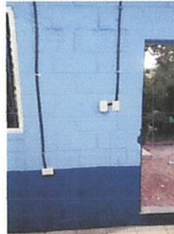
Foto 2: Mejoramiento sistema Electrico, entubar 20 metros lineales de cable No. 10.
