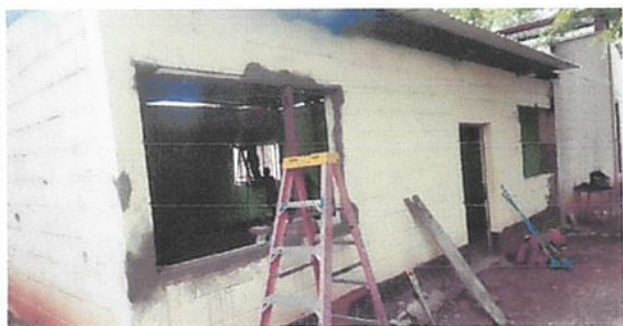
Foto 3: Colocación de Ventanas tipo Pvc con sedazo de 1.71 mts X 1.27 mts
