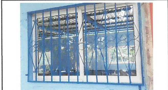
Foto 10: Mantenimiento de balcones de 1.75 mts X 1.30 mts, Limpieza, Refuerzos y Pintura
